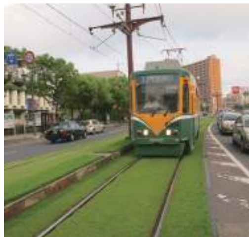
▲市電線路に敷き詰められた緑化基盤材 全長13kmに向けて工が進んでいます。
