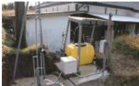
▲車両が近づくセンサーが反応し、消毒液が自動で噴射します。
